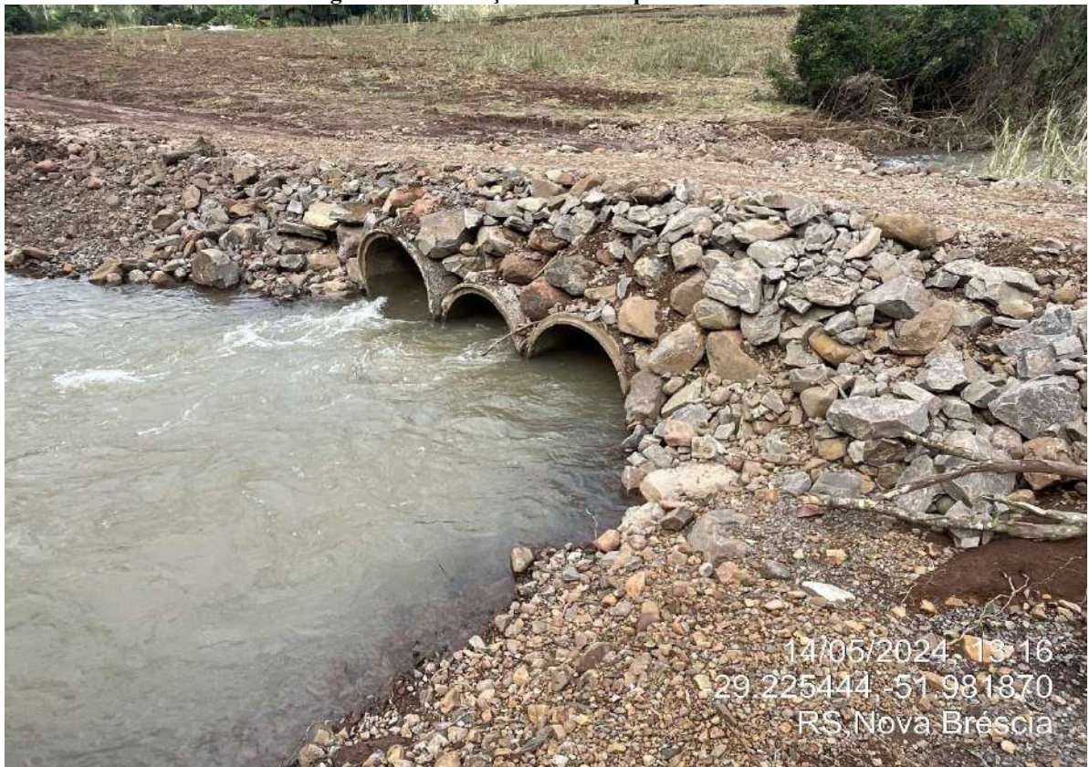
Imagem 3 – Tubulação instalada provisoriamente
