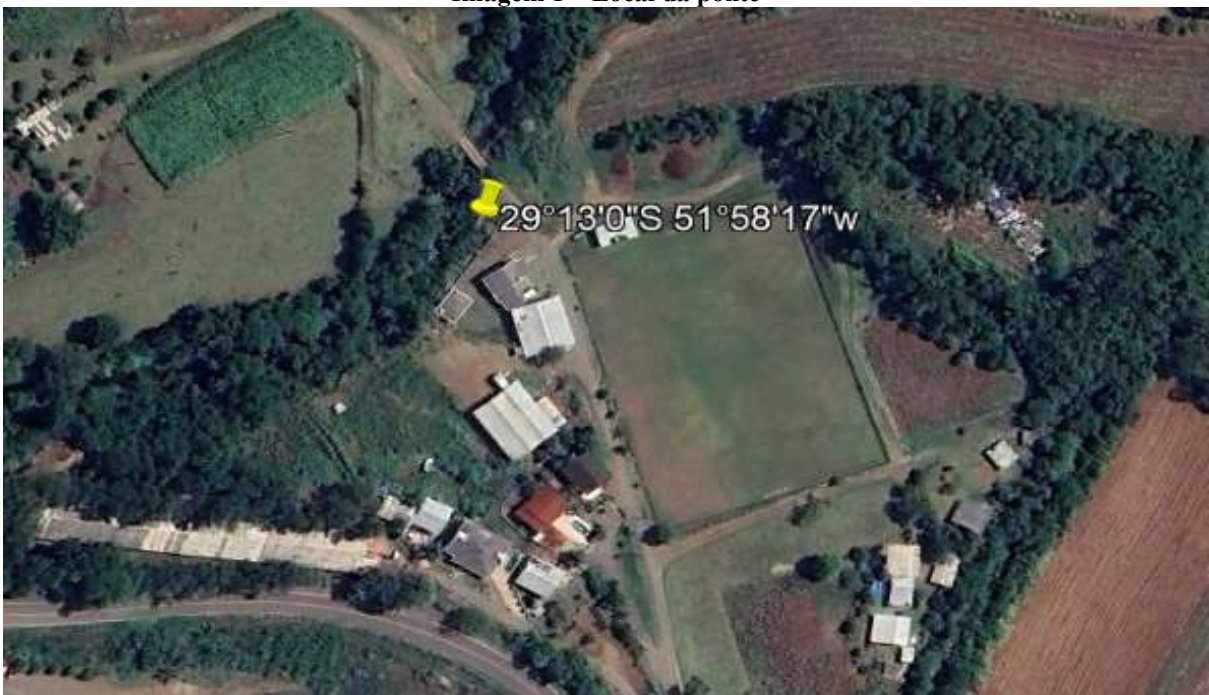
Imagem 1 – Local da ponte
